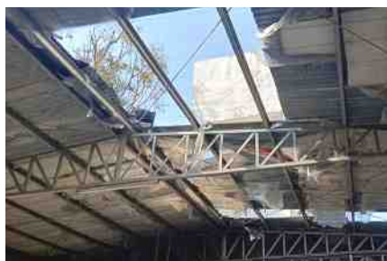
Dach von Kantine in Minglanilla
