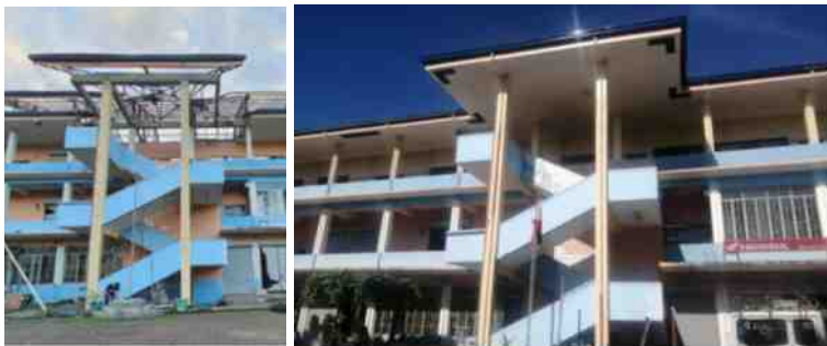
Das Dach vom Don Bosco Zentrum in Punta Princesa nach Taifun Rai sowie nach den von uns finanzierten Dachreparaturen. Vielen Dank allen Spender:innen!
